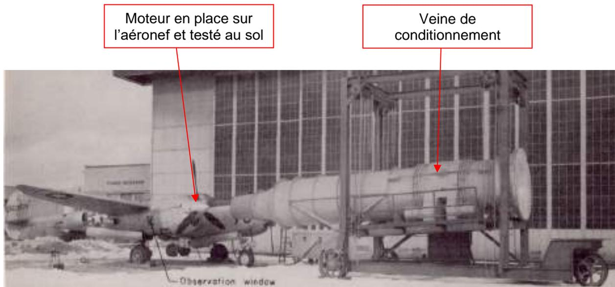
Figure 23 : Illustration d'un montage d'essais sur une installation motrice complète
